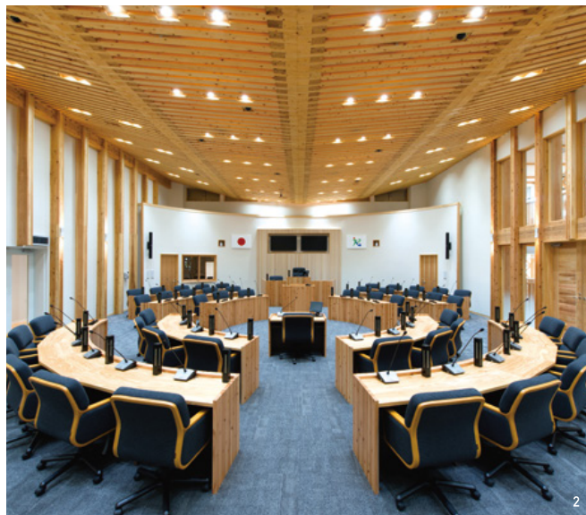
1／東館側からの外観 2／議場内。天井には張弦梁を採用し、迫力ある木の空間を形成 3／本館の格子建具を内側から見る。床はスギの圧密フローリング
